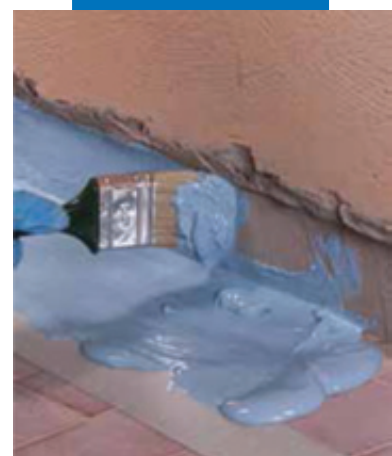
Нанесение Mapelastic AquaDefense кистью на стык между полом и стеной перед укладкой Mapelband
