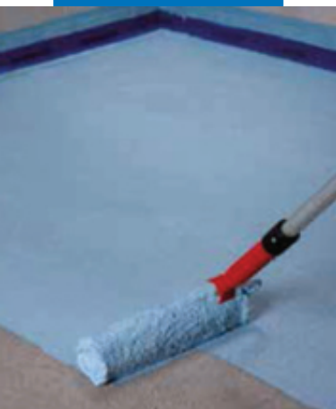
Нанесение первого слоя Mapelastic AquaDefense на стяжку
