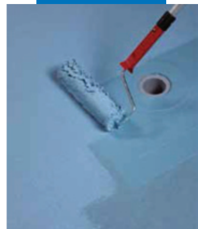
Нанесение валиком второго слоя Mapelastic AquaDefense
