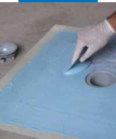
Пропитка ткани Drain Vertical составом Mapelastic AquaDefense
