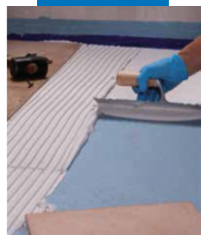
Приклеивание плитки на Mapelastic AquaDefense
