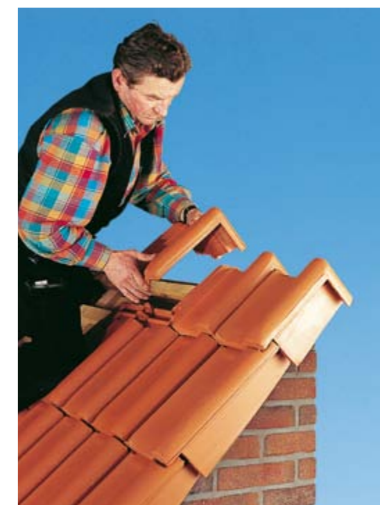
Для завершения односкатной кровли была разработана черепица специальной формы. Как для замыкания конька, так и для боковин. Она рассчитана для замыкания кровли при наиболее распространенных углах наклона. По Вашему желанию мы можем изготовить также специальные элементы, рассчитанные на другой угол наклона.
