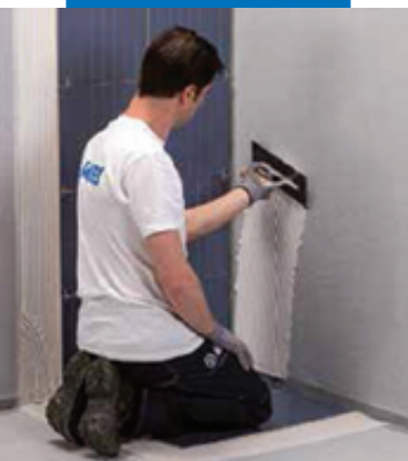
Укладка настенного покрытия с применением Keraflex Maxi S1
