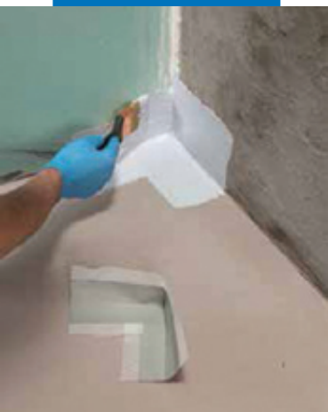
Приклеивание углового элемента MAREBAND PE 120 90° с применением MAREGUM WPS
