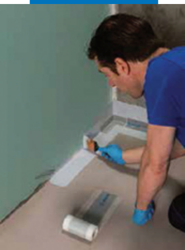
Приклеивание MAREBAND PE 120 с применением MAREGUM WPS
