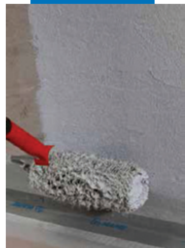
Нанесение Mapegum WPS валиком
