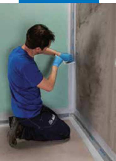
Приклеивание MAREBAND PE 120 с применением MAREGUM WPS
